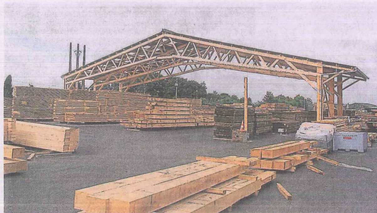
Le bâtiment de 37 m de large est en construction dans la cour de l'entreprise.
