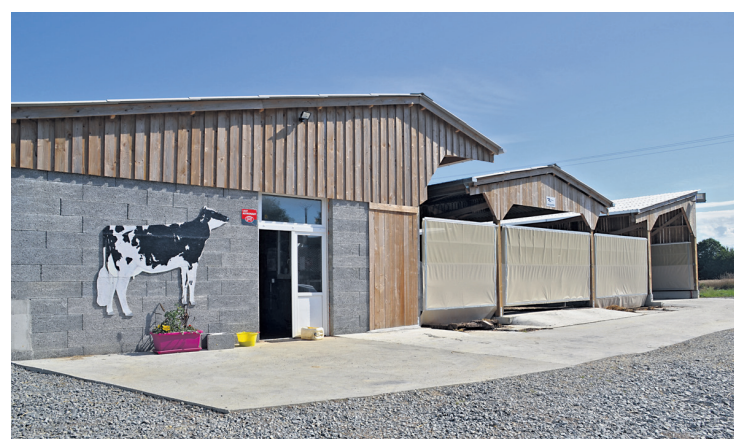
Sur les pignons ont été installés des filets brise-vent.
