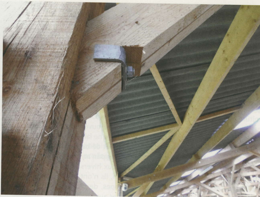
Détails de l'assemblage des éléments.
