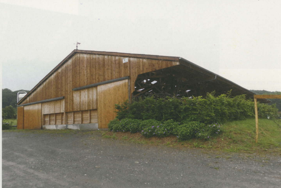
Vue générale du bâtiment des frères Bastin.
