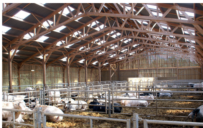
La portée des charpentes peut aussi atteindre 40 mètres sans poteaux.
